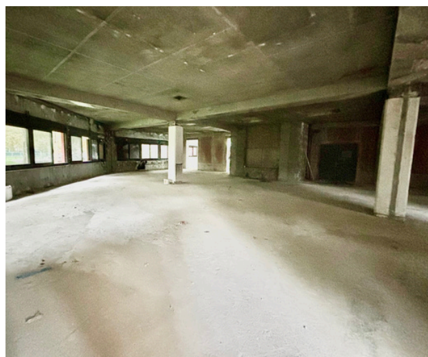
Avant d'entamer les travaux, tout l'espace de l'ancien restaurant incendié a été mis à nu
